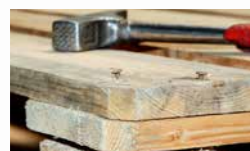
Einschlagen herausstehender Befestigungselemente
