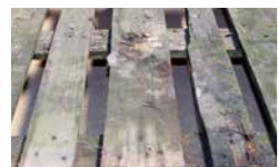
Trocknung/Reinigung durchnässter Bretter
