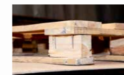
Sichtbare Befestigungselemente z. B. Nägel
