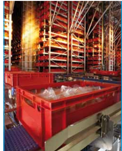
Hightech vom Feinsten: Das vollautomatische Hochregallager
