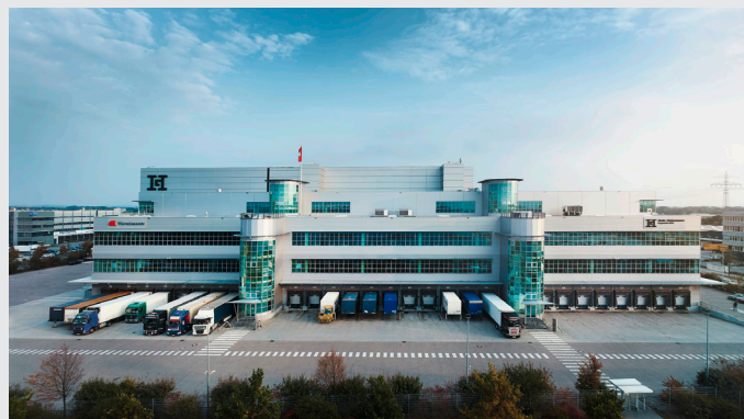
Gebr. Heinemanns Motor der Distribution – die Logistikzentren in Allermöhe (im Bild) und Erlensee
