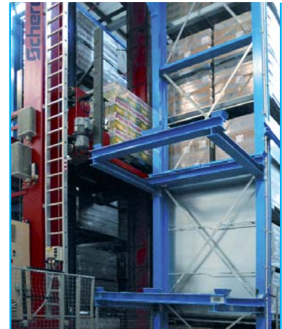
Abbildung 9: Übergabeplatz mit RFID-Reader
